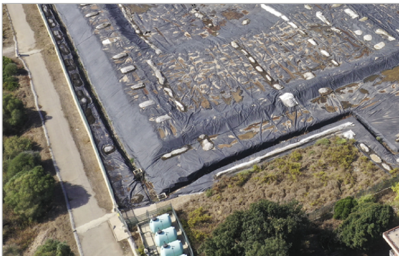
Figura 4.7 - Stralcio porzione sud-est Area Palte: è evidente il sistema di canalizzazione perimetrale per il convogliamento delle acque meteoriche e i serbatoi di accumulo con rilancio al CIPSS.
